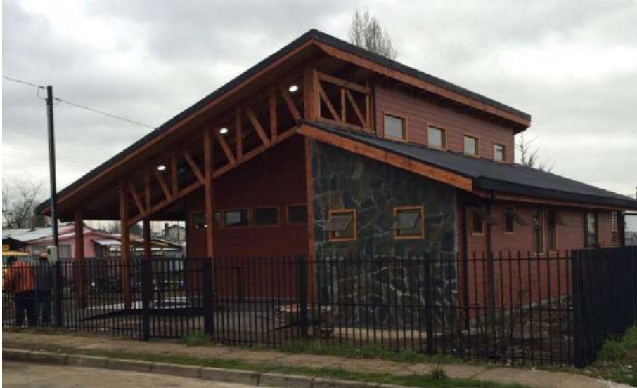
Sede de la Unión Comunal de Juntas de Vecinos de San Pablo Llano en calle Colon c/Pilmaiquen.
