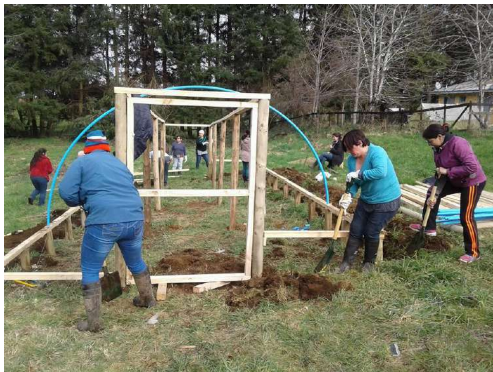
Construcción colectiva de invernadero en LaPoza. Año 2017.
