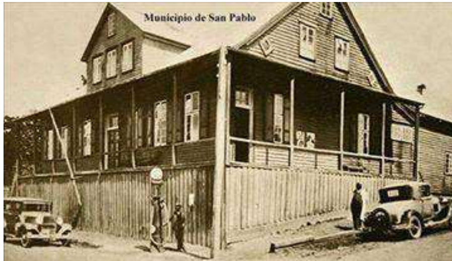
Vista de Esq. Bolivia c/Colon, edificio municipal de San Pablo, sin ochavo, años 30 S.XX
