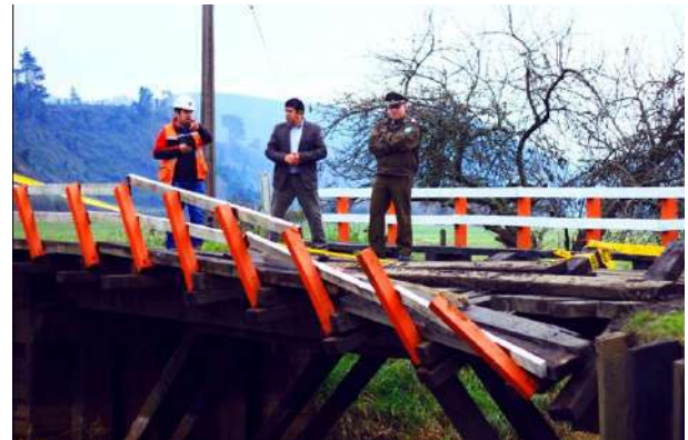
Puente Trumao 1, Ruta U-100
